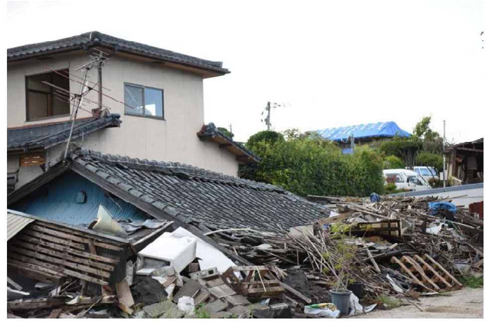
益城町の様子 片付けはこれからのところも
