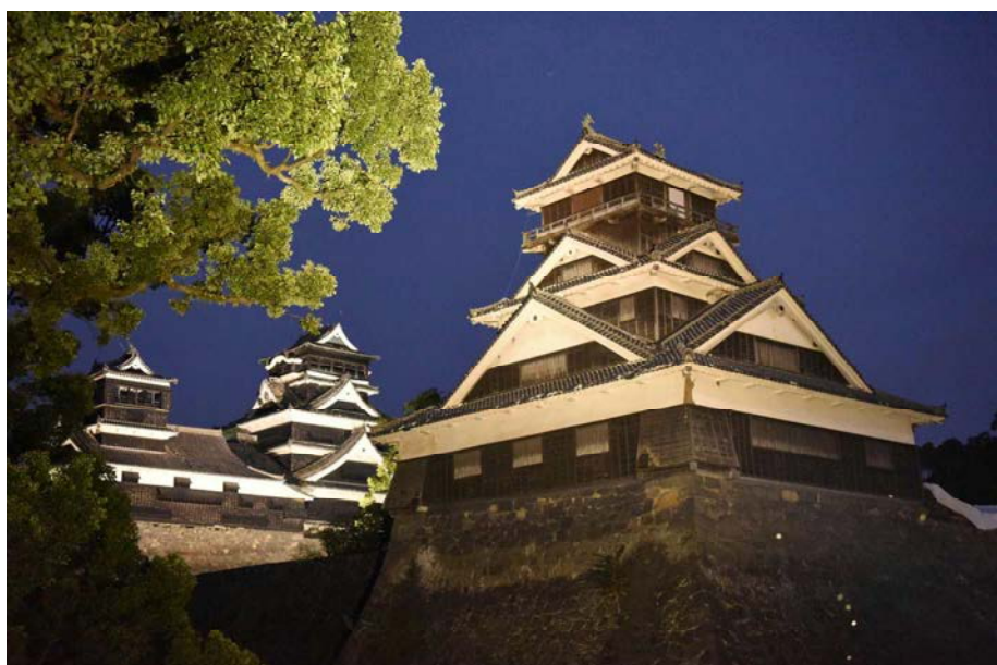
熊本城 被災しながらもしっかりと立っていました
