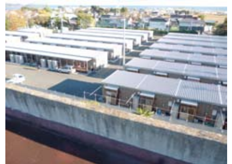
グラウンドにある仮設住宅（校舎屋上から）
