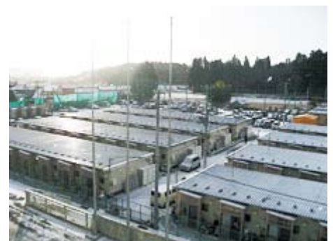
校庭に設置された仮設住宅
