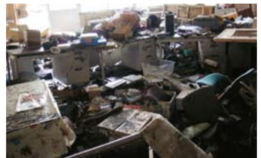
1階職員室の状況
