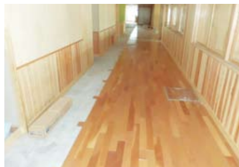
被災した校舎1階の床・壁張替作業
