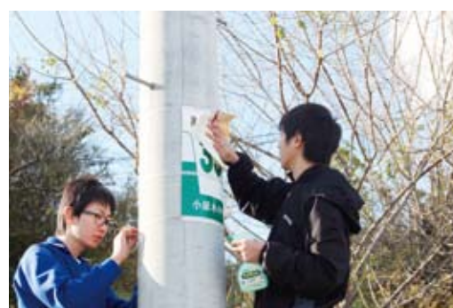
海拔表示板の修理
