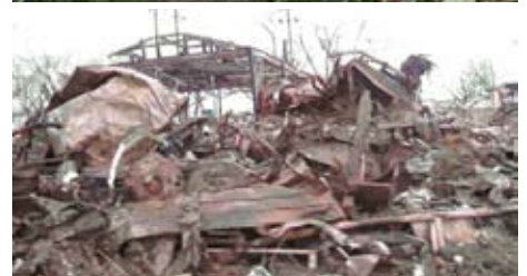
目々澤職員撮影、南気仙沼駅付近の状況
