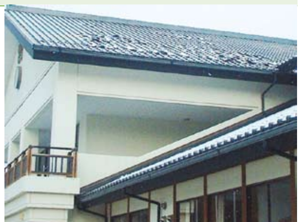
破損した屋根瓦
