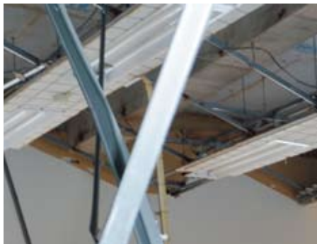
音楽室の天井落下
