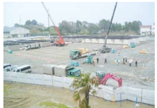
仮設住宅建設が開始された校庭
