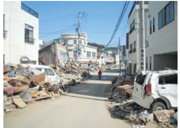
通学路の危険箇所実地踏査
