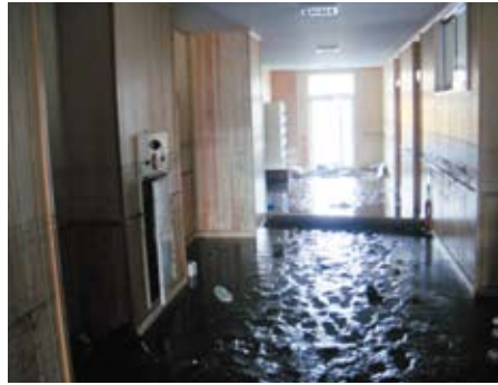
廊下一面に堆積したヘドロ
