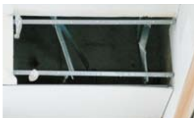
天井、側面の壁のはがれ
