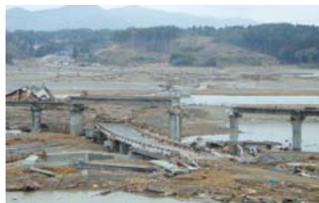
橋は流失、線路は崩壊
