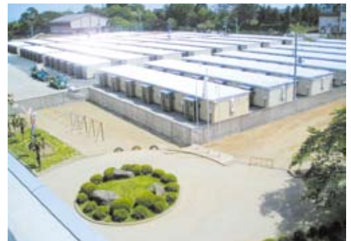
校庭に完成した186戸の仮設住宅
