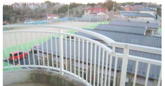
校庭に建設された仮設住宅である。約20世帯の地域の方々が居住している。本校児童の家庭も数家庭含まれている。地域や関係者の方々のご尽力により校庭が1/3程確保された。[平成24年1月撮影]
