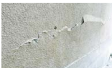
各所に壁面の亀裂
