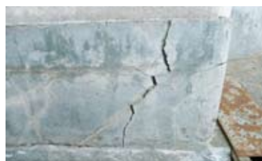
各所に壁面の亀裂
