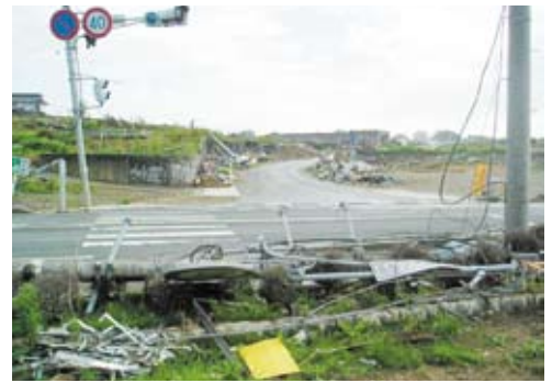
破壊状態の大谷海岸駅付近
