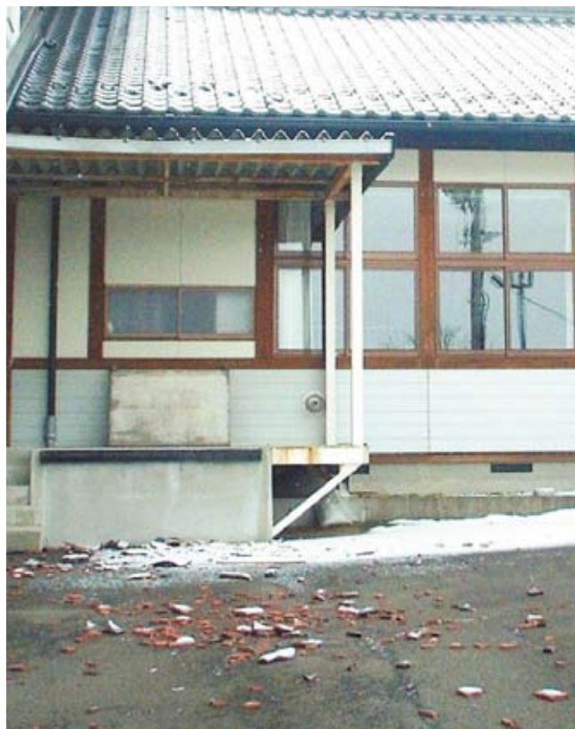
落下した瓦の破片
