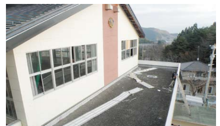
体育館の軒天が落下
