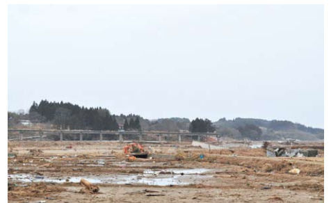
河口から1.5km地点 高架橋の線路が完全に流された気仙沼線
