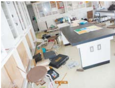
理科室の損壊
