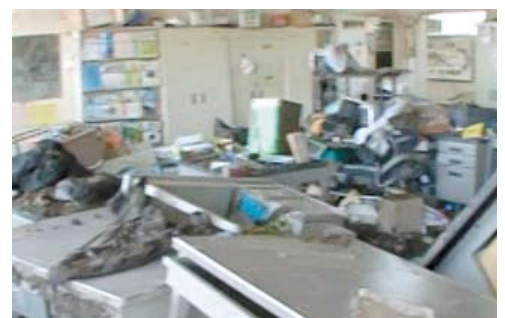
職員室後方(西側)の様子
