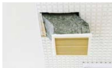
エアダクト4基落下等で教室使用不可
