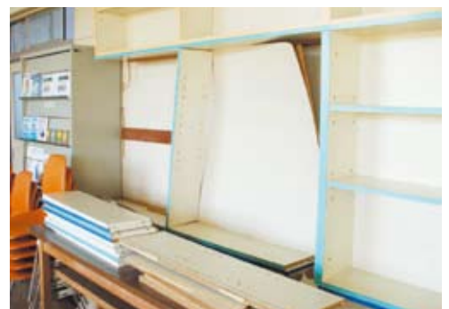
地震で壊れた図書館
