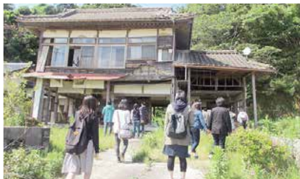
解体できない津波の被害を受けた家屋 (南相馬市村上地区)
