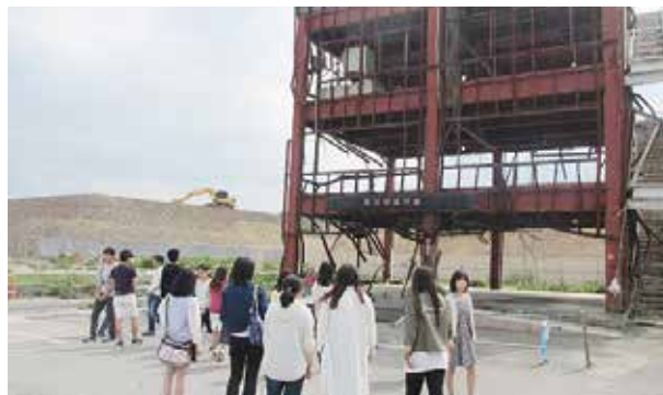
津波で被災した防災庁舎の見学 (南三陸町志津川地区)
