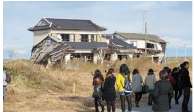
津波被災後、解体できないままの家屋～小高区村上地区～
