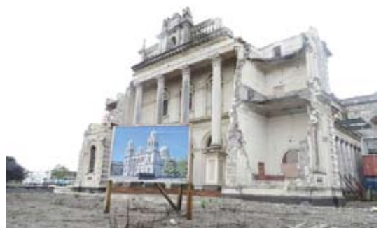
平成 23 年 2 月に被災したクライストチャーチ市内の遺構
