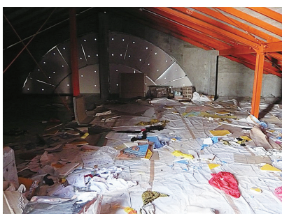
写真10 緊急避難場所となった中浜小学校の屋上倉庫 (2013.9.28. 撮影) 児童たちはここで一夜を過ごした。
