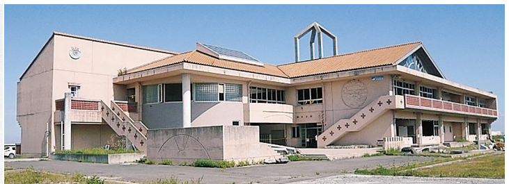
写真06 中浜小学校全景 (2013.9.28. 撮影) 津波は2階の軒下にまで到達していた。
