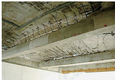
写真 29 1 階から見上げた写真 28 と同一場所 (2013.6.20. 撮影) 津波の力によって床スラブは梁から引き剥がされている。
