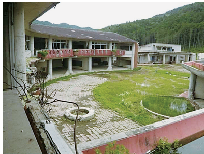
写真 26 2 階から中庭を望む (2013.6.20. 撮影)
