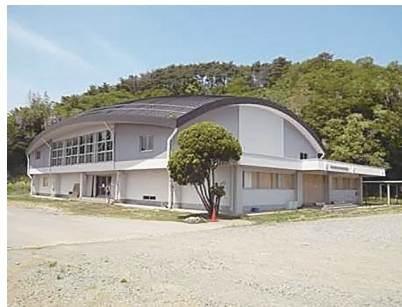
写真17 緊急避難場所となった野蒜小学校の体育館（2013.6.1.撮影） 体育館に避難していた人々はその後高さ5mの津波に襲われた。
