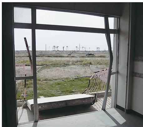
写真04 荒浜小学校2階廊下妻面の被災状況(2013.4.20.撮影) 津波はこの海側妻面から2階にまで侵入していた。
