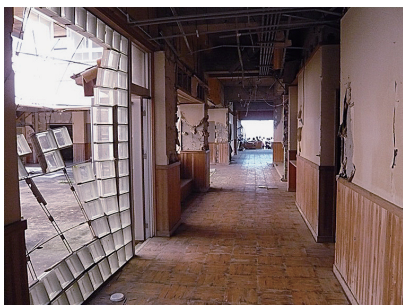
写真07 中浜小学校1階廊下の被災状況 (2013.9.28. 撮影) 津波は中廊下を突き抜けて侵入してきた。
