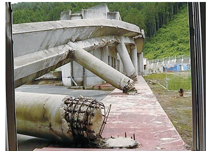
写真 27 2 階から見た渡り廊下 (2013.6.20. 撮影)
