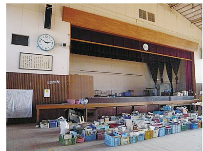
写真 16 閑上小学校体育館の時計は 14:47 で止まっている (2013.6.1. 撮影)
