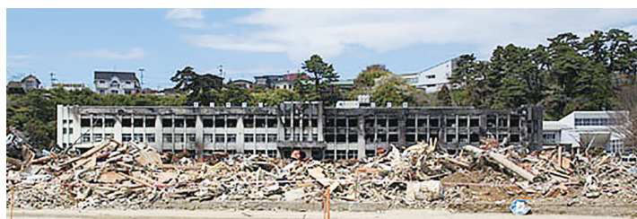
写真19 津波火災を受けた門脇小学校（2011.8.11.撮影） 児童たちはいち早く背後の高台に避難していた。
