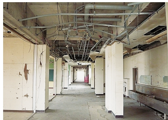
写真03 荒浜小学校1階廊下の被災状況(2013.4.20.撮影)
