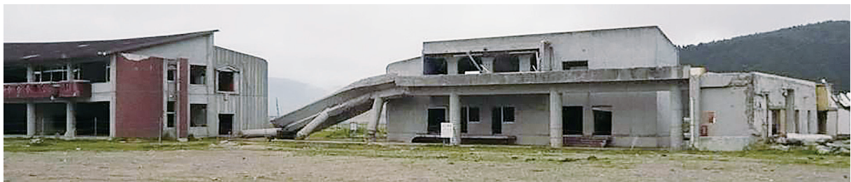
写真 24 津波で押し倒された渡り廊下 (2013.6.1. 撮影)
