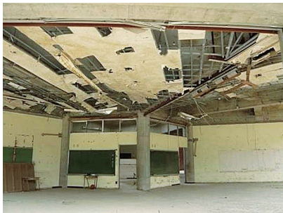
写真 25 円形校舎 1 階部分の被災状況 (2013.6.1. 撮影)
