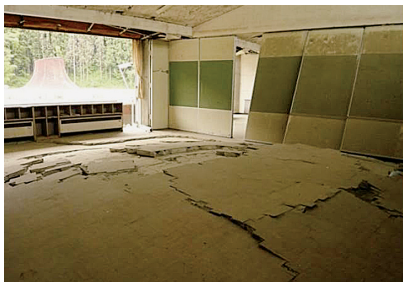
写真 28 津波で床面が押し上げられた 2 階の教室 (2013.6.20. 撮影)
